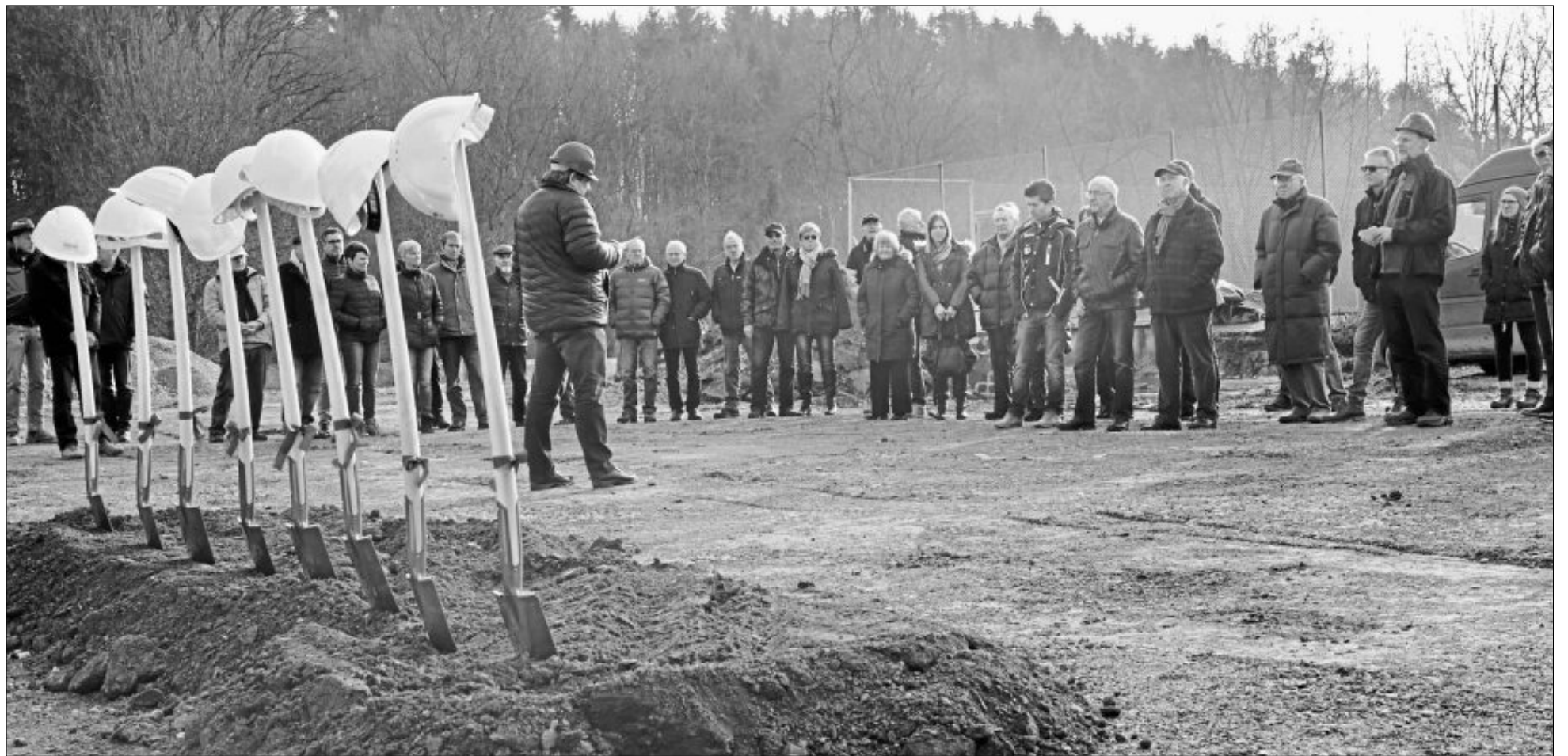
Harald Lutz begrüßt die Gäste beim offiziellen Spatenstich. Von der alten Halle ist nichts mehr zu sehen.
